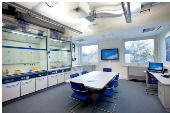
Předvádění systému v předváděcí laboratoři TROX, Neukirchen-Vluyn, Německo
