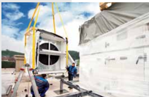
Dodávka a montáž jednotky X-CUBE ve venkovním provedení
